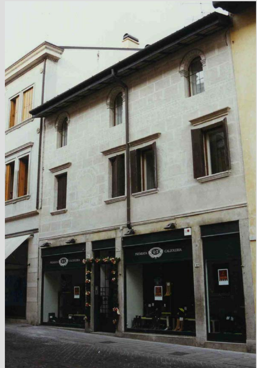
Facciata dopo il restauro
