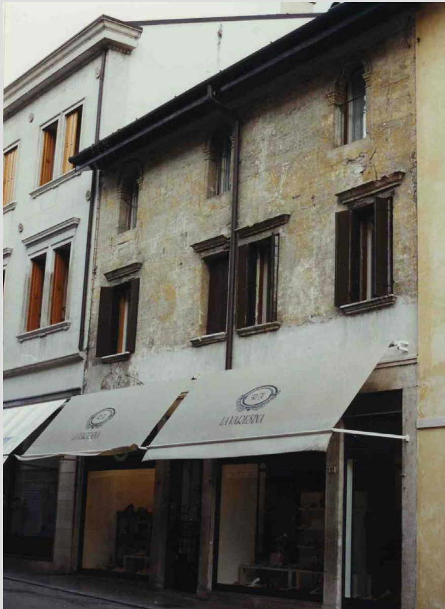
Facciata prima del restauro
